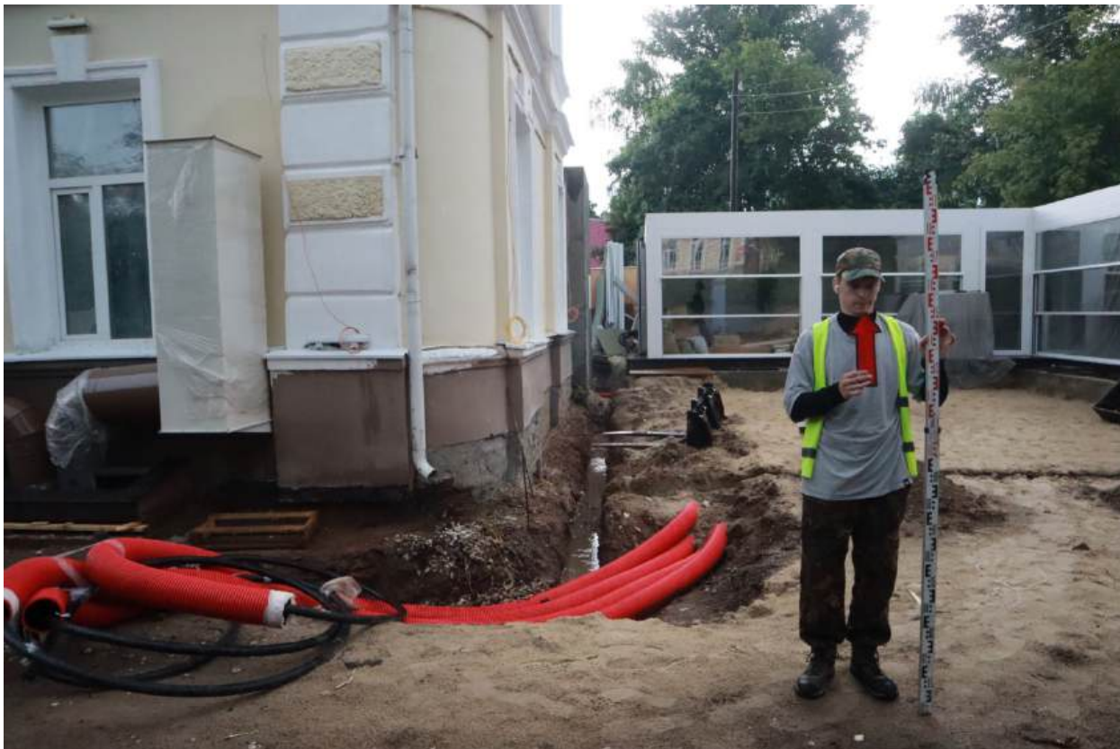
Рис. 10. Обеспечение сохранности ОКН федерального значения «Культурный слой города» в г. Нижний Новгород. 2026г. Точка фотофиксации 1. Вид с Ю.
